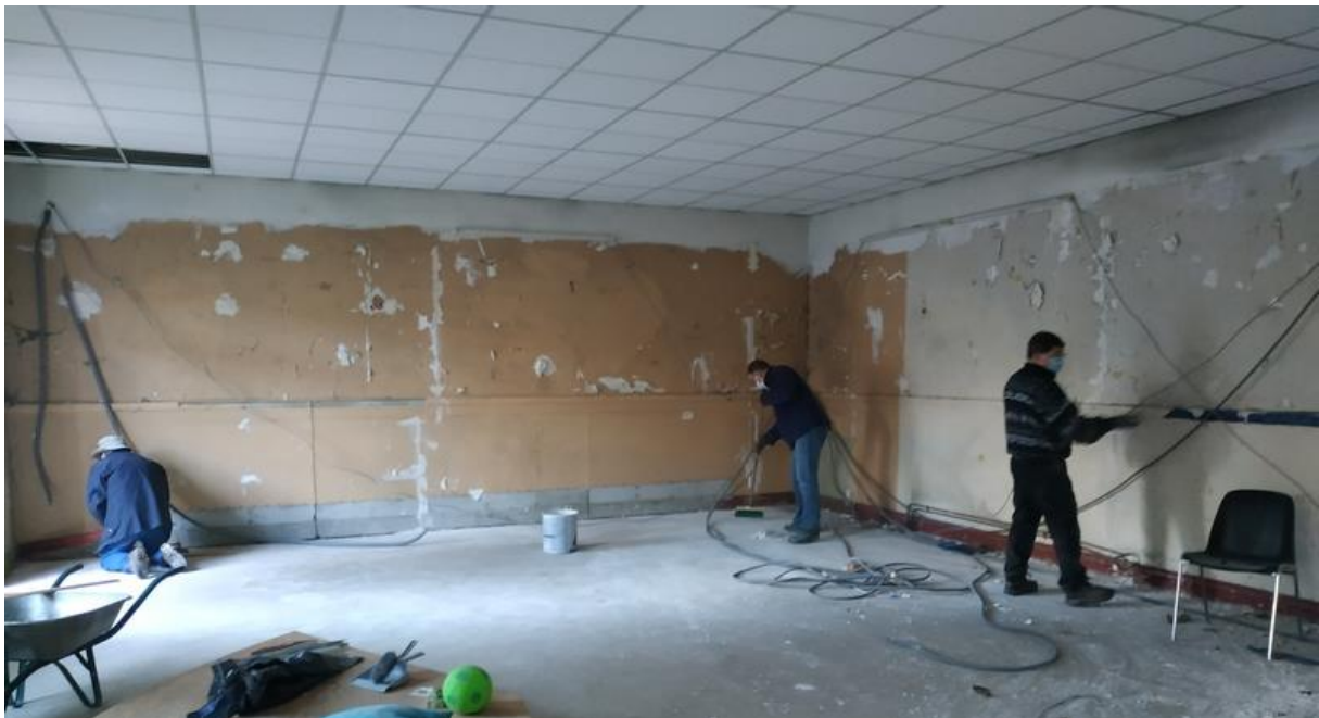
des pré-travaux réalisés salle Jonas avec quelques paroissiens
